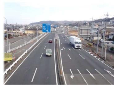
国道18号 (交差点改良区間)
