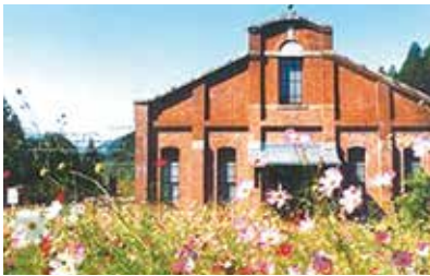
▲旧丸山変電所
