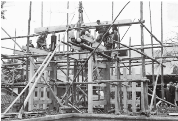
碓氷関所東門復元工事 昭和34年
