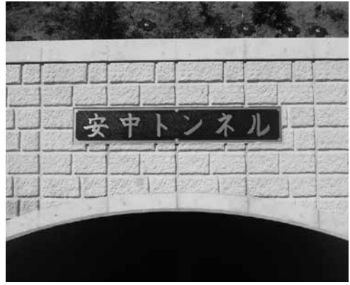
▲トンネル出入口の銘板
