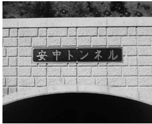
▲トンネル出入口の銘板
