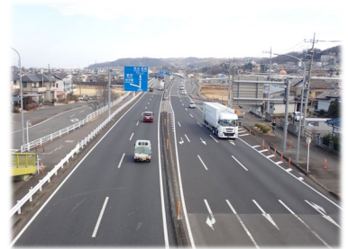
国道18号 (交差点改良区間)
