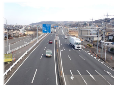
国道18号 (交差点改良区間)
