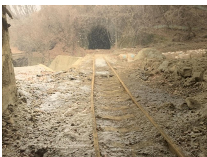
上り線 4 号トンネル入口
