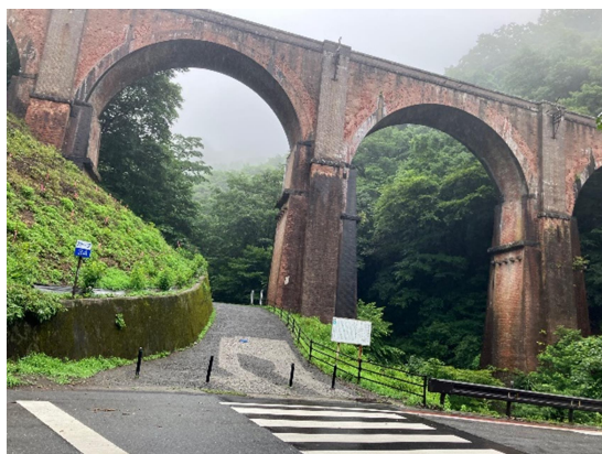
碓氷第三橋梁(めがね橋)
