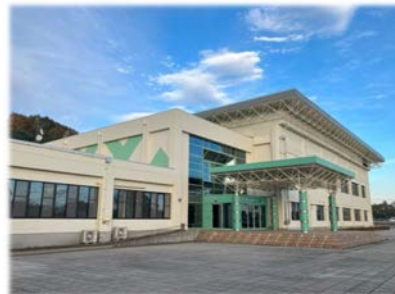
安中市スポーツセンター
