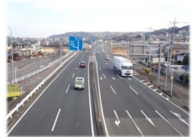
国道18号 (交差点改良区間)
