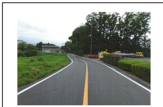
市道幹 127 号線道路維持工事 (すみれヶ丘聖苑南)
