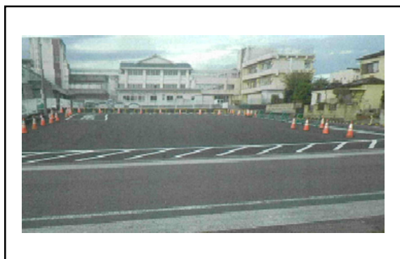
原市小学校スクールバス 昇降所整備工事
