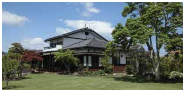
浦野邸(東上磯部) 所有者：浦野 敬治 設計者・施工者：(有)中島建設
