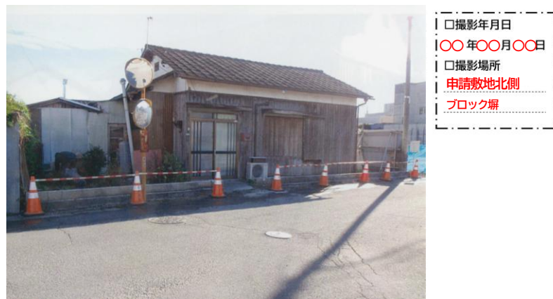
図8 撤去後の状況が確認できる写真の例
