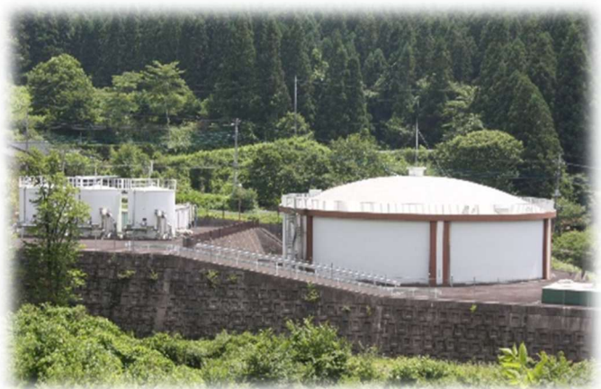
一ノ瀬配水池兼浄水池（右）と 急速ろ過機（左）
