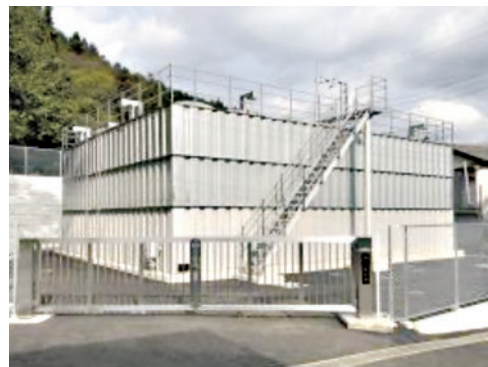
令和5年3月竣工の榎木配水池(五料地内)
