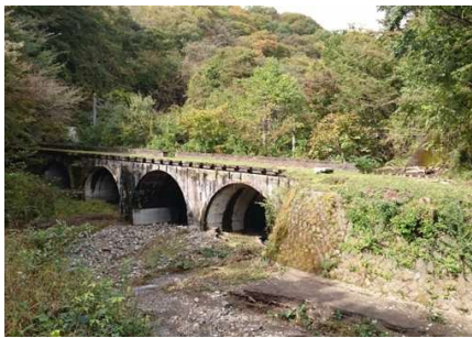
碓氷第 13 橋梁(中尾川橋梁)
