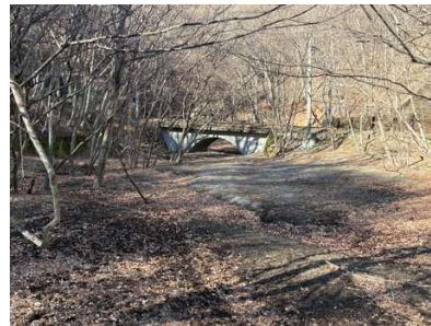
上り線・下り線の間中部
