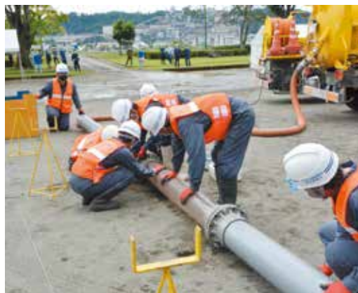
▲道路やライフラインなどの応急復旧訓練
