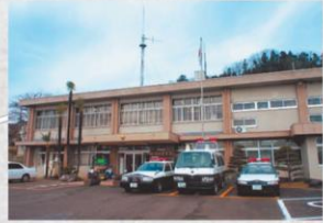
① 安中警察署松井田分庁舎
