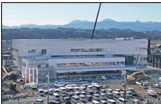
写真 建設中の安中市役所
