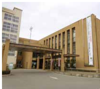
市役所旧本庁舎外観
