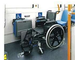
車いす固定装置
