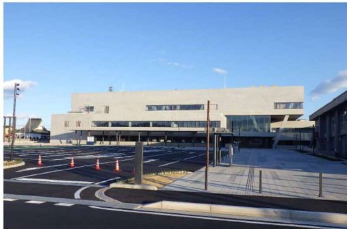
安中市新庁舎建設工事
