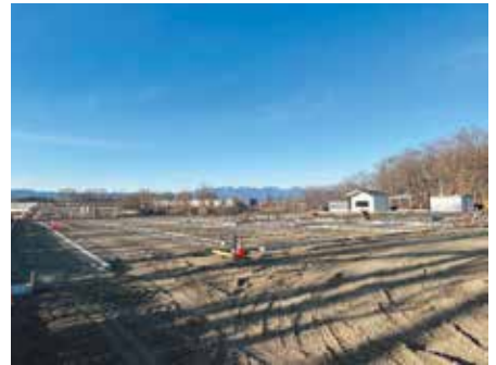
▲区画墓地の工事の様子
