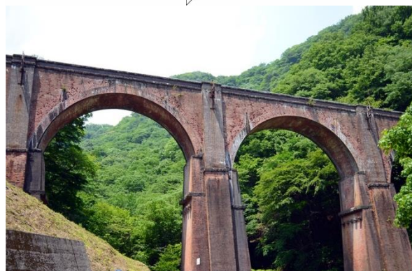
明治以降、アプト式鉄道を支えたレンガ式アーチ橋の碓氷第三橋梁（通称「めがね橋」）。昭和38（1963）年の新線開通に伴い廃線。国重要文化財に指定。
