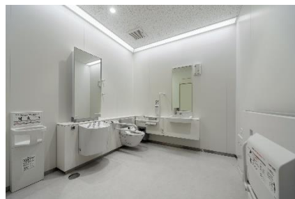
多機能トイレの例（観音寺市役所）
