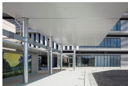
庇のある移動しやすい動線の例 （城里町庁舎）
