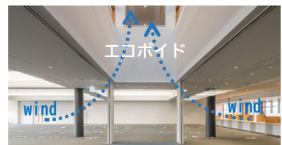
自然通風を促進するエコアイテム例 (上田市役所)
