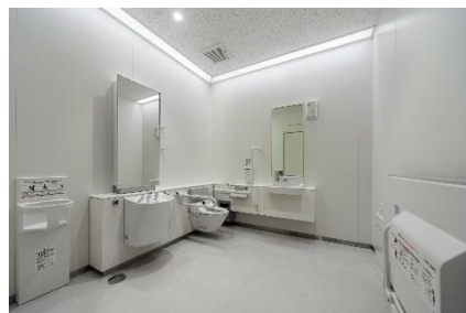
多機能トイレの例（観音寺市役所）
