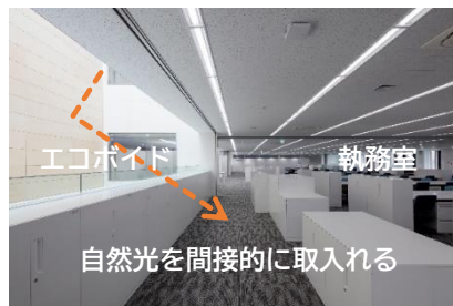
エコボイドによる明るい執務室の例 (新座市役所)
