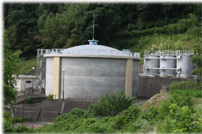
滝ノ入配水池兼浄水池（中央）と 急速ろ過機（右手奥）
