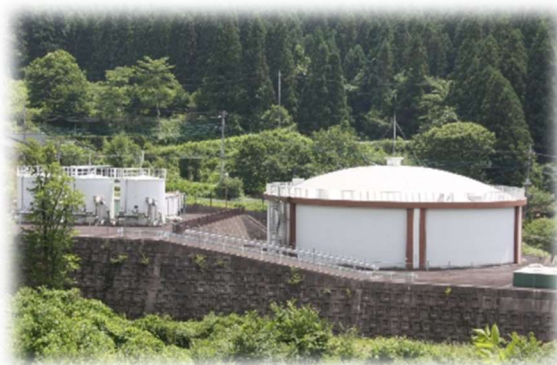
一ノ瀬配水池兼浄水池（右）と 急速ろ過機（左）
