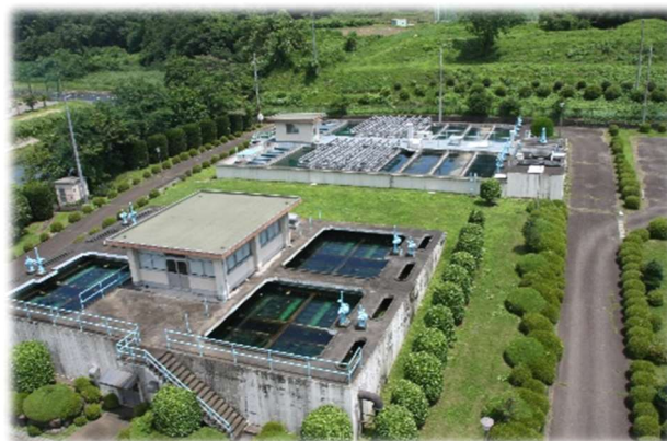
急速ろ過池(手前)と沈殿池(奥)
