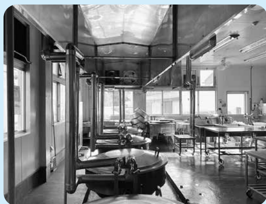
小学校の給食室
