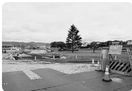
建設中の「あんなかスマイルパーク」
