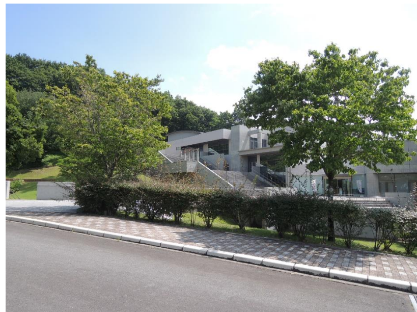
公共施設 市内写真
