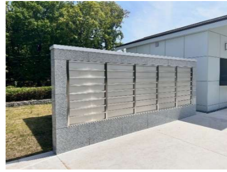
御影石の記名板を設置するための墓誌です
