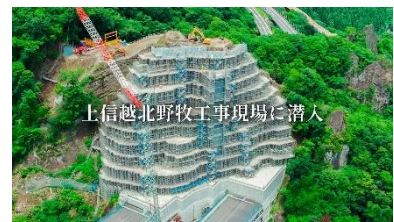
8月25日公開 北野牧トンネル工事
