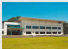
⑤ 安中市スポーツセンター
