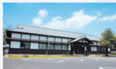
旧碓氷郡役所 市指定重要文化財
