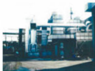
電気炉集塵機設置
