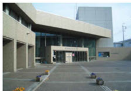
安中市文化センター外観
