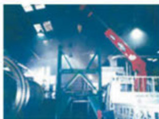
架台取付作業
