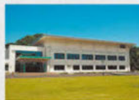
⑤ 安中市スポーツセンター
