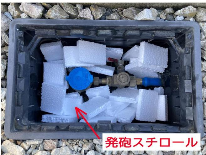
蛇口を少しだけ開けて凍結を防ぐ場合、1分間に0.5L（目安として鉛筆の芯の太さくらい）の水を出してください。上記の場合で仮に1日中出しておくと1日当たりの料金が120円くらいになります。凍結し破損した場合の修理費を考えれば負担が少なくなります。
