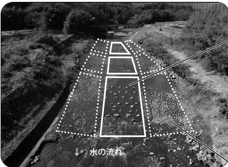
対策の全景 (碓氷大橋から上流を撮影)平成31年3月撮影
