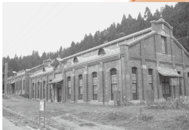
旧丸山変電所 (手前が「蓄電池室」、奥が「機械室」)
