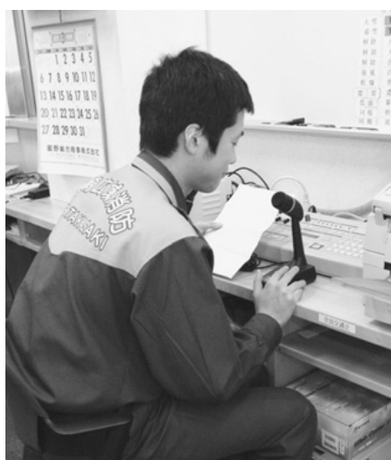
安中消防署に設置された 遠隔制御装置
