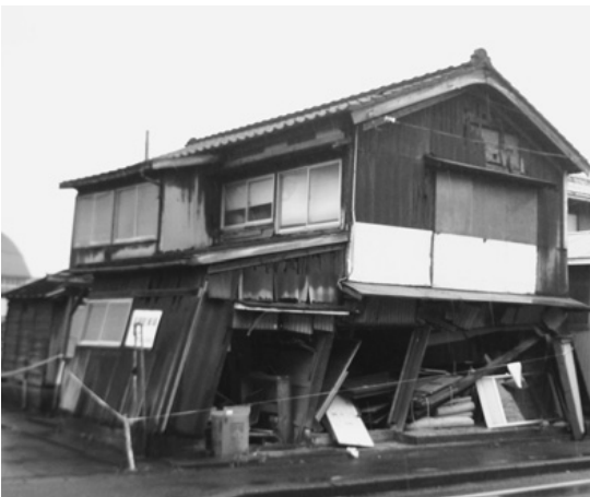
▲新潟県中越沖地震で倒壊した木造住宅
